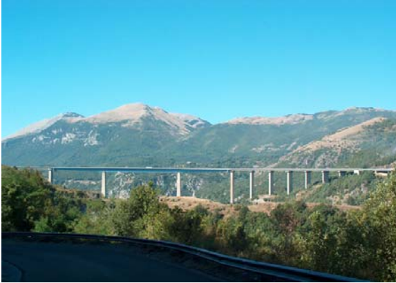
Il ponte Italia della A3 Salerno-Reggio Calabria visto da Laino Castello. Attraversa il Lao in località Capammare.
